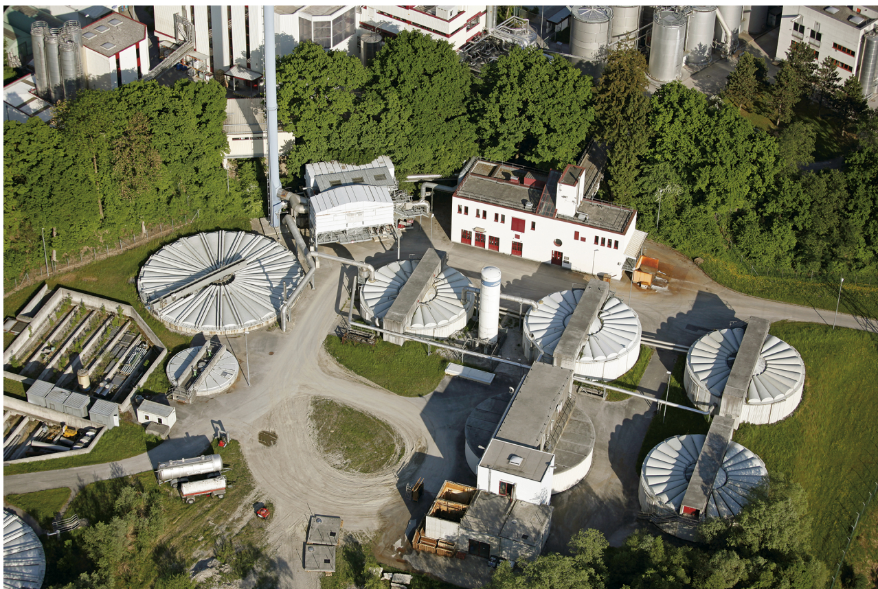
Die werkseigene zweistufige Abwasserreinigungsanlage reinigt Prozessabwässer und schwach belastetes Abwasser aus den Produktionsanlagen in Kundl.
